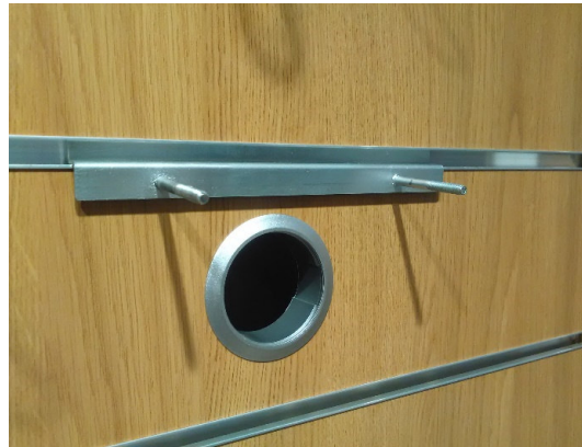
Montagewinkel über Kabelset mittig positionieren
